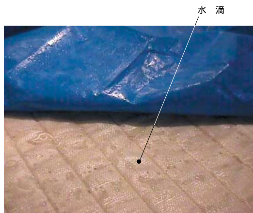
第 11 図 養生マットの状態 (養生) Fig. 11 Condition of curing mat (curing)
