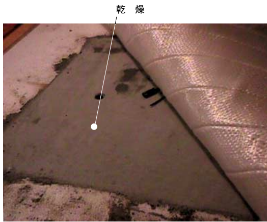
第 10 図 コンクリート表面の状態 (養生) Fig. 10 Condition of concrete surface (curing)
